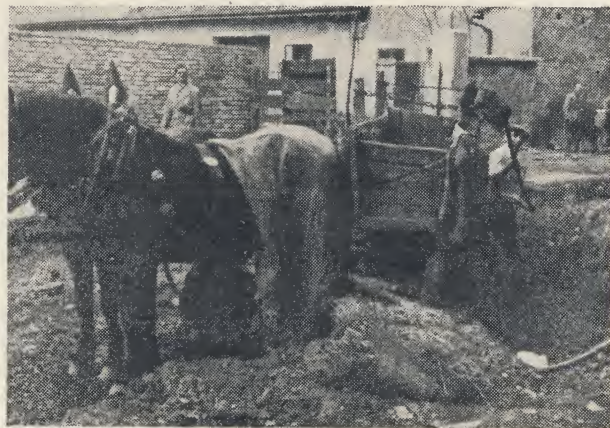
Sl. 3: Utovar i transport iskopanog materijala
